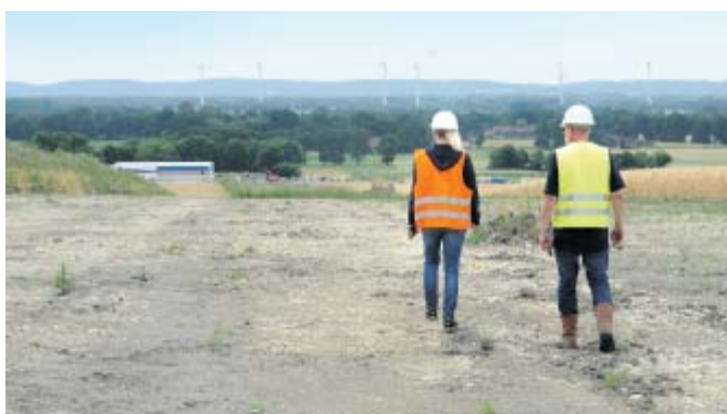
Baustelle mit Aussicht: Die Pipeline führt direkt über den Dielingener Klei zur Übergabe-Station Drohne. Im Süden ist das Wiehengebirge zu sehen.
