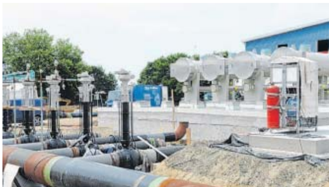
Neubau: Nahe der bestehenden Anlage von „Open Grid Europe“ in Drohne entsteht eine neue Übergabe-Station. Von hier wird das Erdgas in das westdeutsche Netz verteilt.
