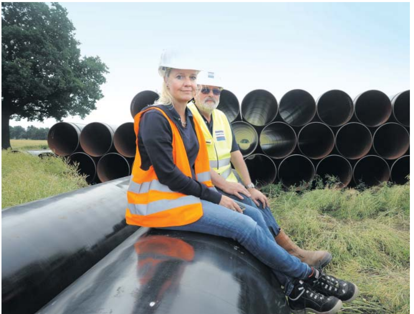
Vor Ort: Gascade-Sprecherin Nicola Regensburger und Gerald Günther als Mitglied der Bauleitung haben das „Nowal“-Projekt im Blick. Auf dem Rohrlagerplatz nahmen beide zum Aufbau der Pipeline Stellung.
