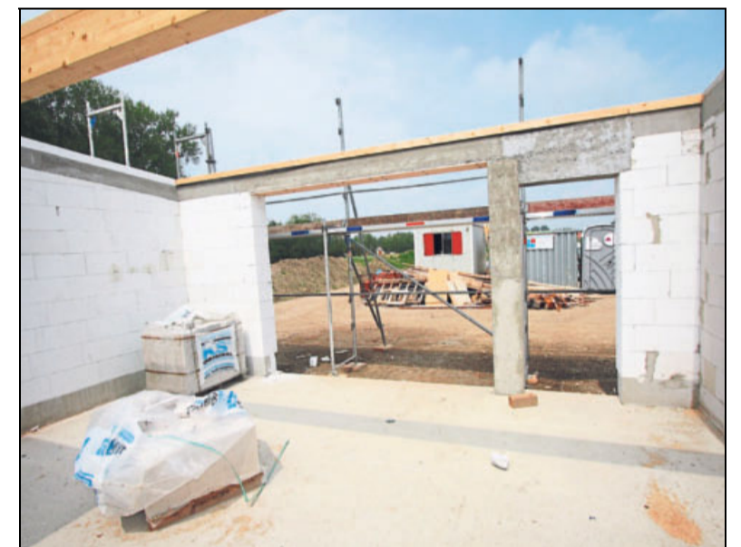
Das Lager ist durch ein Rolltor zugänglich. Derzeit wird alles in Garagen außerhalb des Geländes gelagert.
